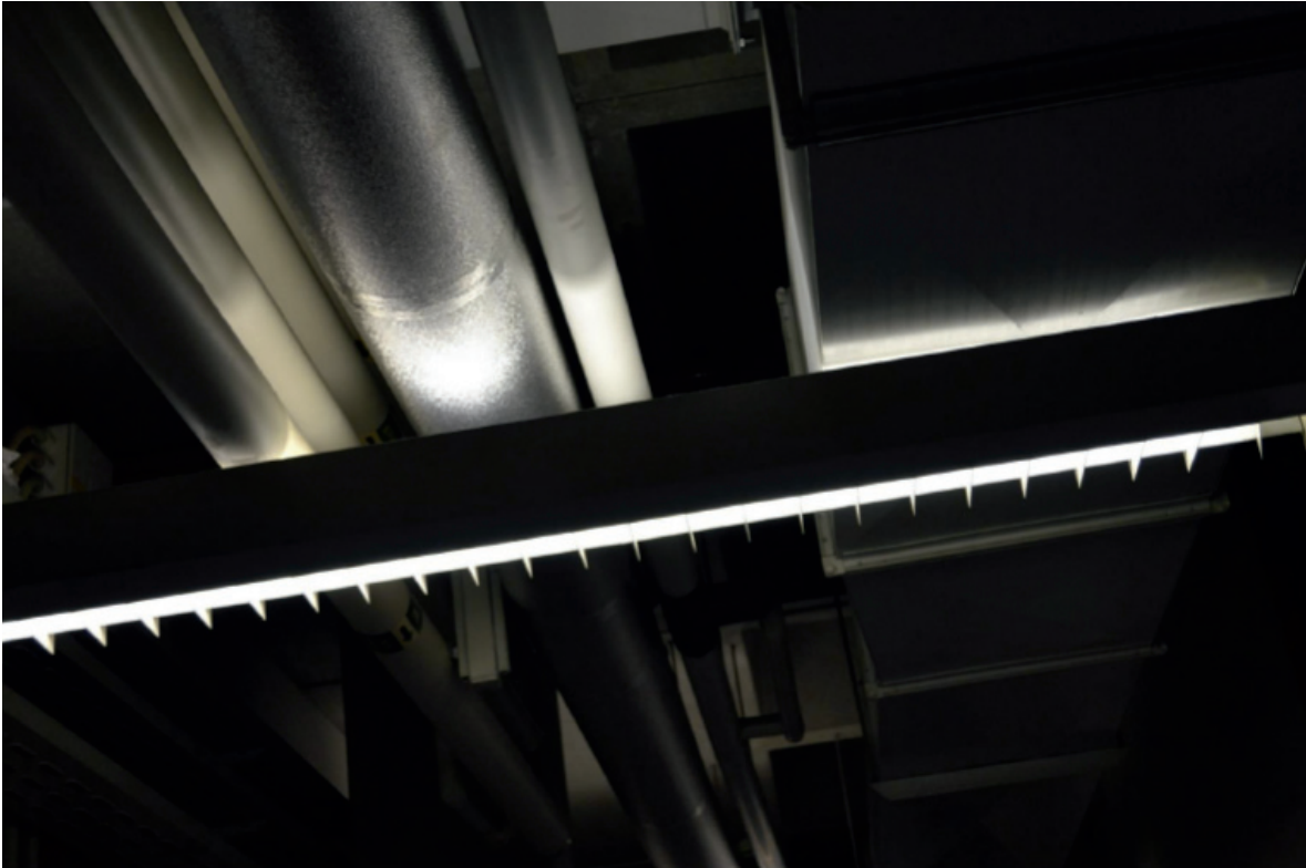
ductwork IV , 2015, Fotografie auf Alu-Dibond, 60 x 90 cm
